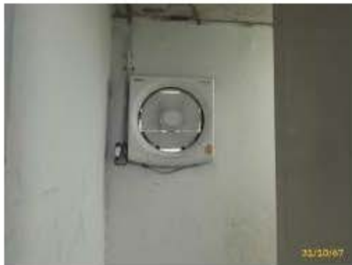
การระบายอากาศแบบวิธีกล
