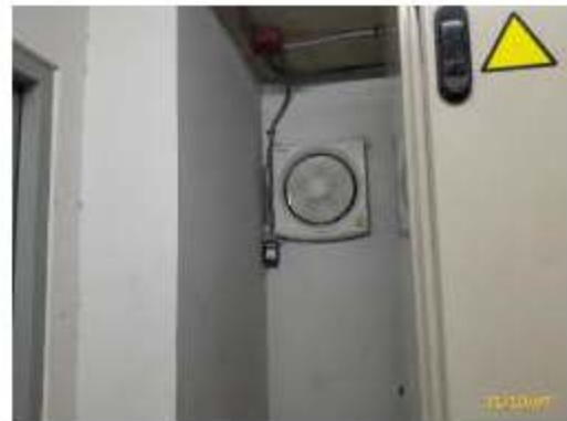
การระบายอากาศแบบวิธีกล
